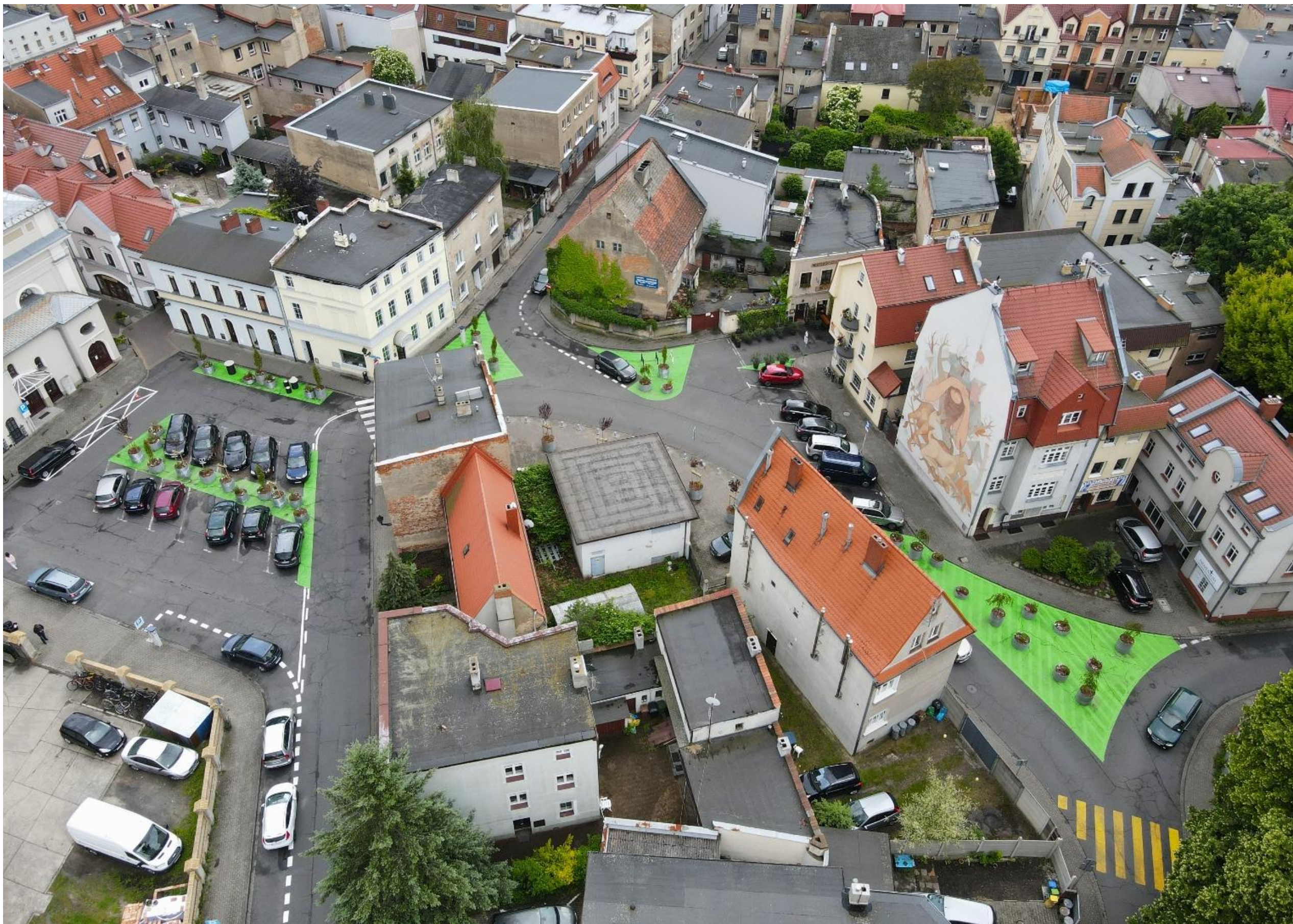
Plac Powstańców po wprowadzeniu nowych rozwiązań – zielone strefy, elementy małej architektury i miejsca odpoczynku
