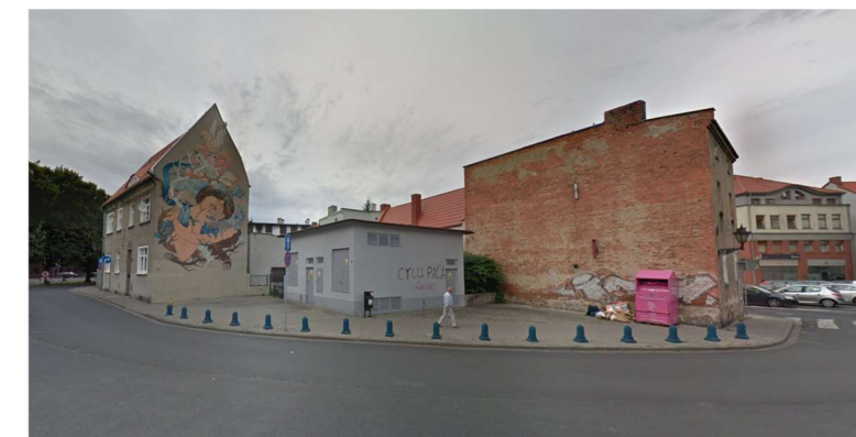
Widok na teren przy trafostacji z ul. Więziennej /google streetview/
