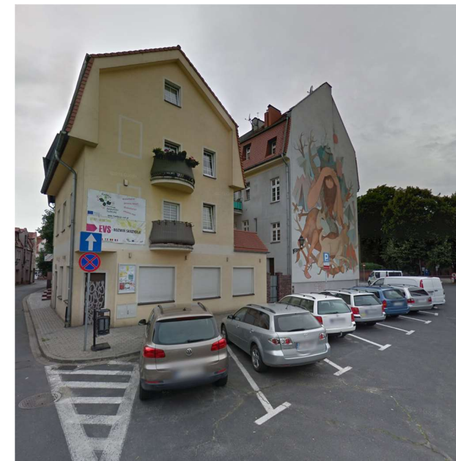
Widok na miejsca postojowe ul. Wałowej /google streetview/
