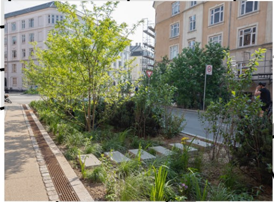
Przykład realizacji ogrodów deszczowych w formie zieleni miejskiej, oddzielającej miejsca postojowe od strefy pieszej – placu/chodnika
