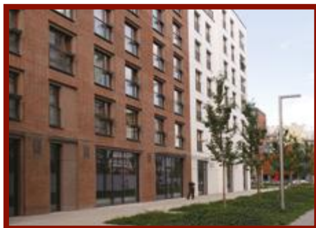
Warszawa Budowa budynku mieszkalnego wielorodzinnego z parterem handlowo-usługowym przy ul. Sierakowskiego 4
