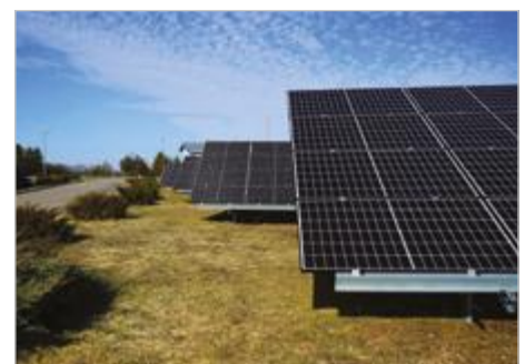
Suwałki Instalacja fotowoltaiczna na terenie PWiK Sp. z o.o. ul. Gen. Sikorskiego 14
