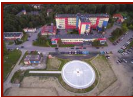
Leżajsk Budowa ładowiska dla śmigłowców ratunkowych na terenie SP ZOZ ul. Leśna 22
