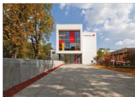
Zabrze Rozbudowa, nadbudowa i przebudowa budynku oraz budowa placu zabaw przy Przedszkolu nr 43 ul. Kolonowa 2
