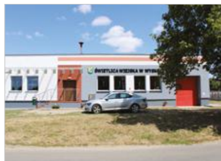
Wyskoć Termomodernizacja świetlicy wiejskiej w Wyskości wraz z montażem OZE Wyskoć 5A
