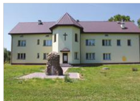
Marcyporeba Termomodernizacja Budynku Zgromadzenia Najświętszej Rodziny z Nazaretu ul. Marka Radwanity 58
