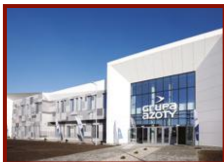
Tarnów Budowa Centrum Badawczo-Rozwojowego Grupy Azoty
