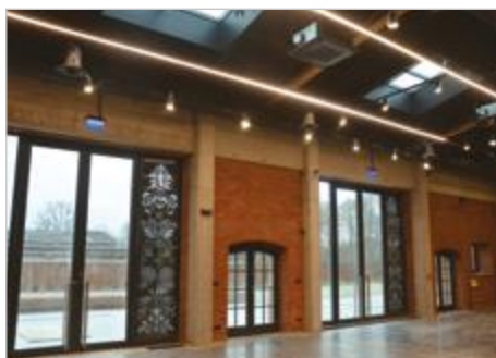
Żukowo Przebudowa zabytkowego spichlerza ul. 3 Maja 9c
