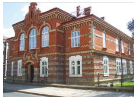
Ropczyce Adaptacja zabytkowego budynku Kasy Oszczędności na Powiatowe Centrum Edukacji Kulturalnej ul. Mickiewicza 10
