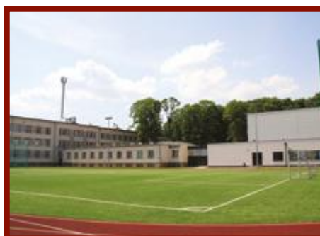
Warszawa Budowa Zespołu Szkolnego przy ul. Dzieci Warszawy Szkoła Podstawowa nr 360
