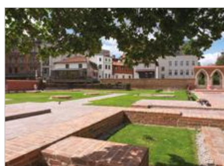
Toruń Prace konserwatorskie ruin kościoła i klasztoru poddominikańskiego wraz z zagospodarowaniem otoczenia -etap II pl. Dominikański
