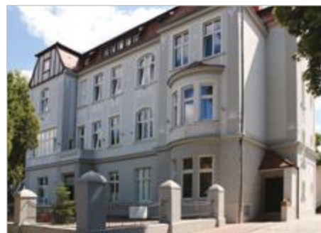
Ostrzeszów Remont Powiatowego Centrum Pomocy Rodzinie w Ostrzeszowie ul. Zamkowa 17
