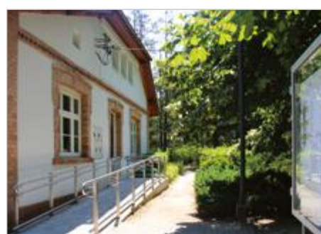
Podkowa Leśna Termomodernizacja budynku Urzędu Miasta Podkowa Leśna ul. Akcyjowa 39/41
