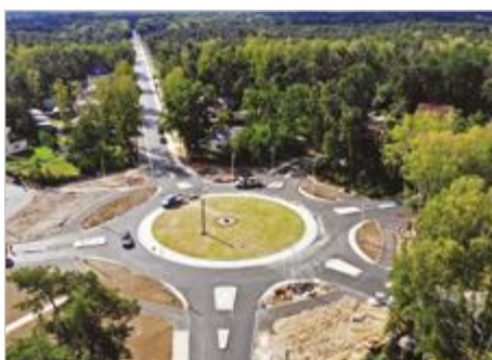
Międzybórz Rozbudowa i przebudowa ul. Wojska Polskiego wraz z budową ronda
