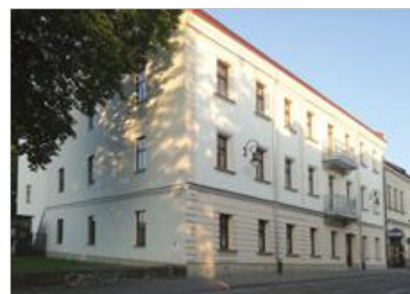
Nowy Sącz Gruntowny remont kamienicy przy ul. ks. Piotra Skargi 12 w Nowym Sączu - Jezuickie Centrum Edukacji
