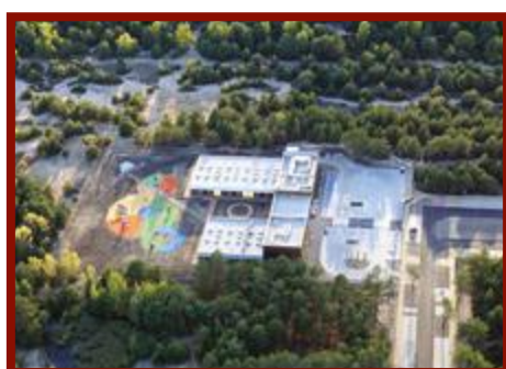
Toruń Budowa budynku przedszkola 10-oddziałowego przy ul. Grasera 1- 3
