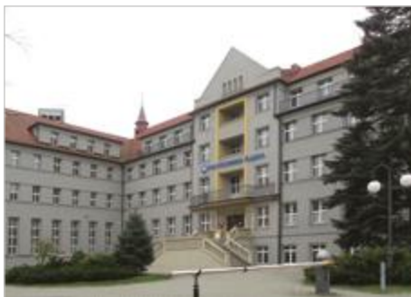
Rybnik Remont budynku Politechniki Śląskiej - Centrum Kształcenia Inżynierów w Rybniku ul. Kościuszki 54
