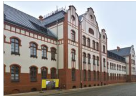
Leszno Budynek Mieszkalny - dawne Koszary Artylerii Polowej ul. Dąbrowskiego 4-6
