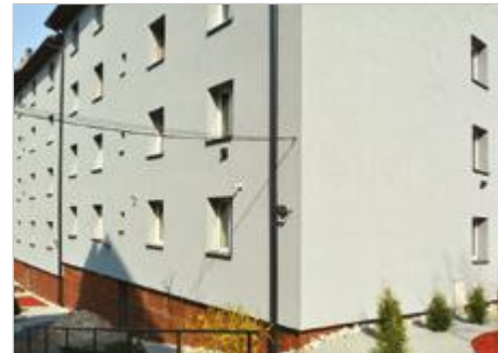
Bytom Budynek Mieszkalny Wielorodzinny przy ul. Powstańców Śląskich 29-31, Rudzkiego 17-19
