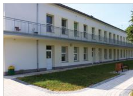
Myślenice Zaprojektowanie i przebudowa oraz modernizacja pomieszczeń Oddziału Zakaźnego SP ZOZ ul. Szpitalna 2
