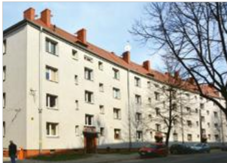
Bytom Budynek Mieszkalny Wielorodzinny przy ul. Woźniaka 48-62
