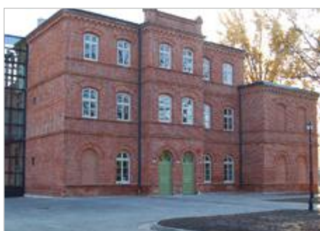
Pabianice Termomodernizacja budynku przy ulicy Partyzanckiej 56
