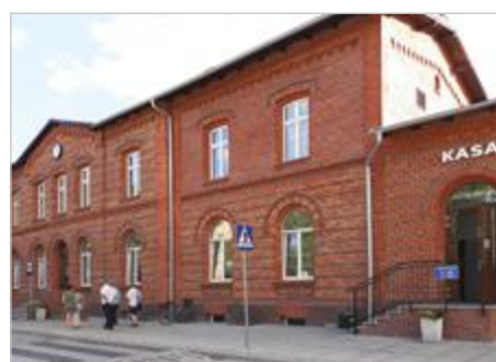
Wołów Modernizacja Dworca PKP w Wołowie ul. Kolejowa 1
