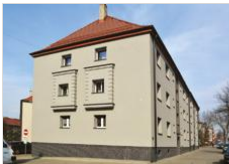
Bytom Budynek Mieszkalny Wielorodzinny przy ul. Strzelców Bytomskich 31 A-D, al. Legionów 51-59
