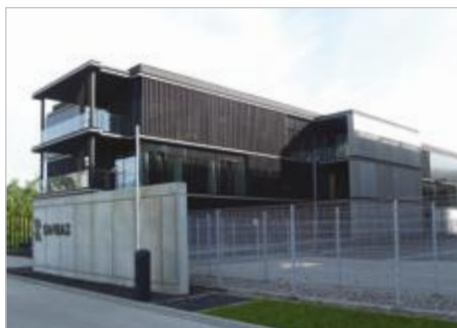
Poznań Modernizacja z przebudową budynek biurowego Zremb ul. Zwierzchowskiego 1
