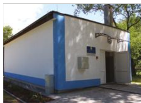
Zalesie Stacja Uzdatniania Wody
